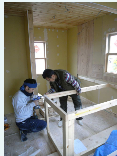
↑2×4フレーミングの現場レクチャー風景(T邸) ←天井材の余りでキッチン扉を製作(2009年手づくりキッチン教室)
